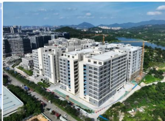
▲航拍君泰滨海智谷项目
