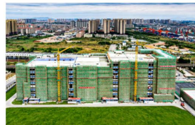
▲石龙首个绿色新材料产业园内部园区内部道路建设（一期）
