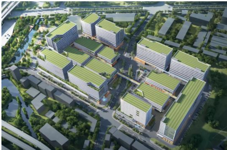
常平领峰智创谷项目（A、B区）
