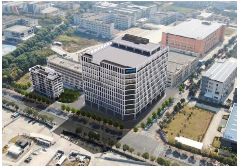
誉华制罐（东莞）有限公司厂区项目
