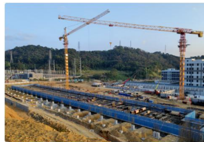
▲东莞500千伏东南输变电工程火热建设中。柏东辉 摄
