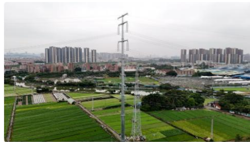
▲220千伏高埗电厂改建1×470兆瓦热电联产机组接入系统工程
